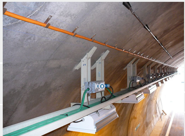
Shirmeck Road Tunnel, Frankrijk
